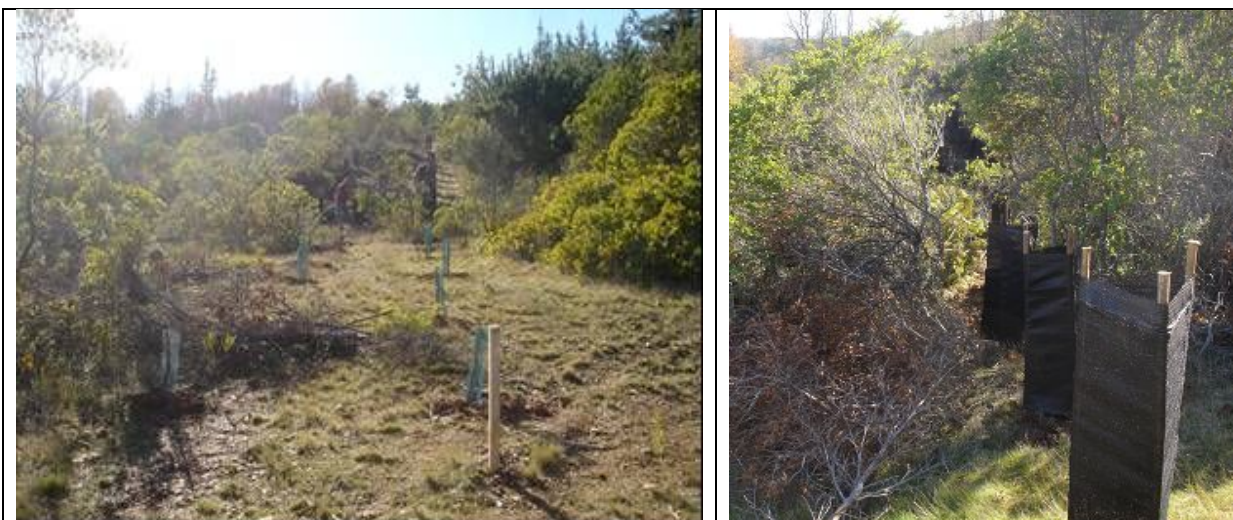
Foto 15: Instalación de mallas de protección en las plantaciones (malla raschell y malla verde plástica)
