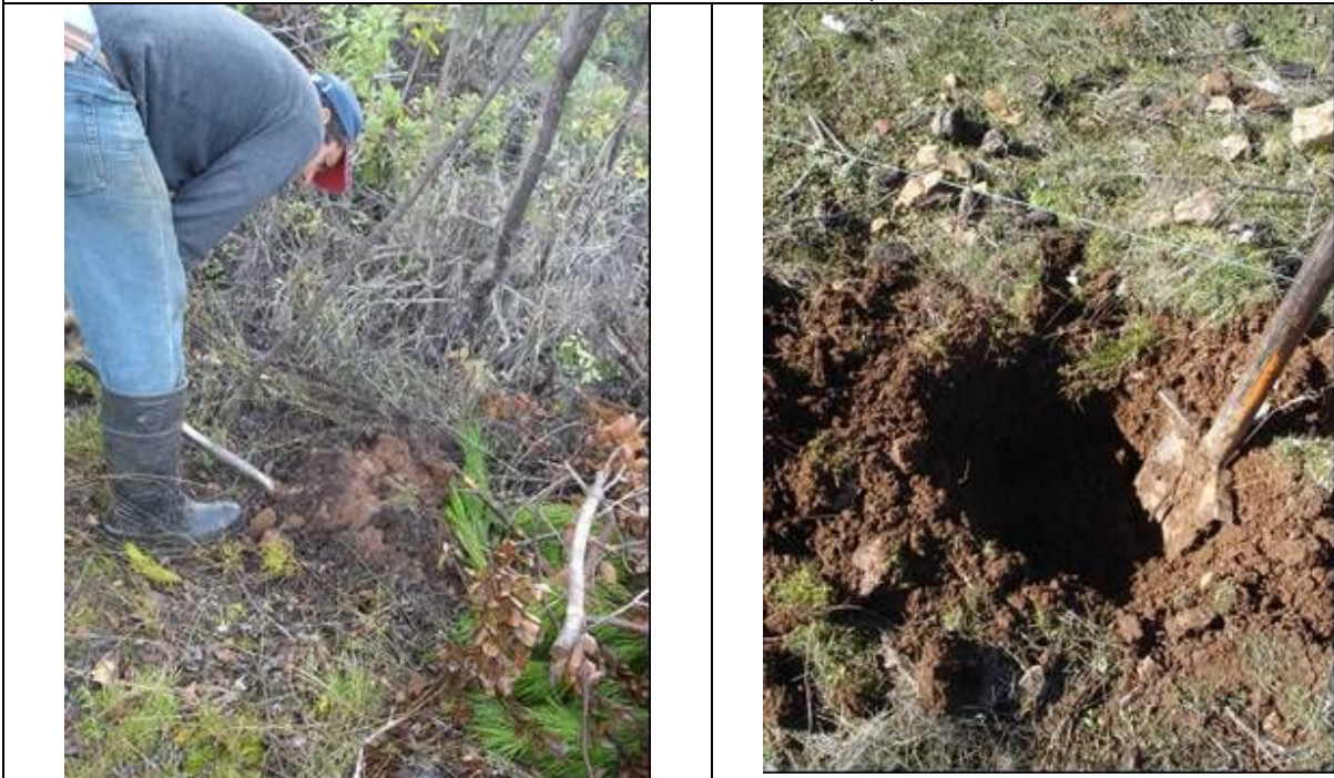
Foto 11: Faenas de hoyadura, previo a la plantación
